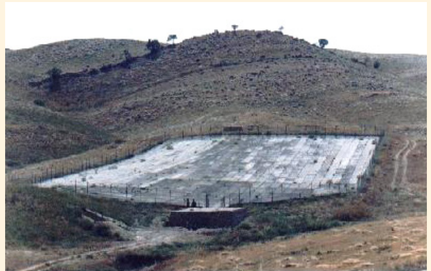
شکل ۵: نمای از سامانه سطح صیقل آب‌انبار
