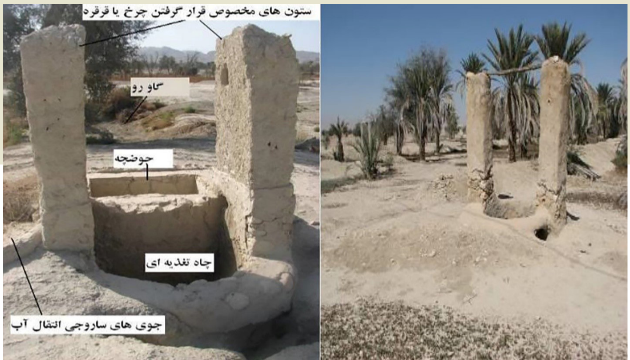
شکل ۱۱: نمایی از یک چاه نزو به همراه اجزاء آن
