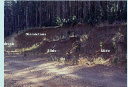
شکل ۲- لغزش دیواره خاکبرداری جاده (ارسکین، ۲۰۰۵)
