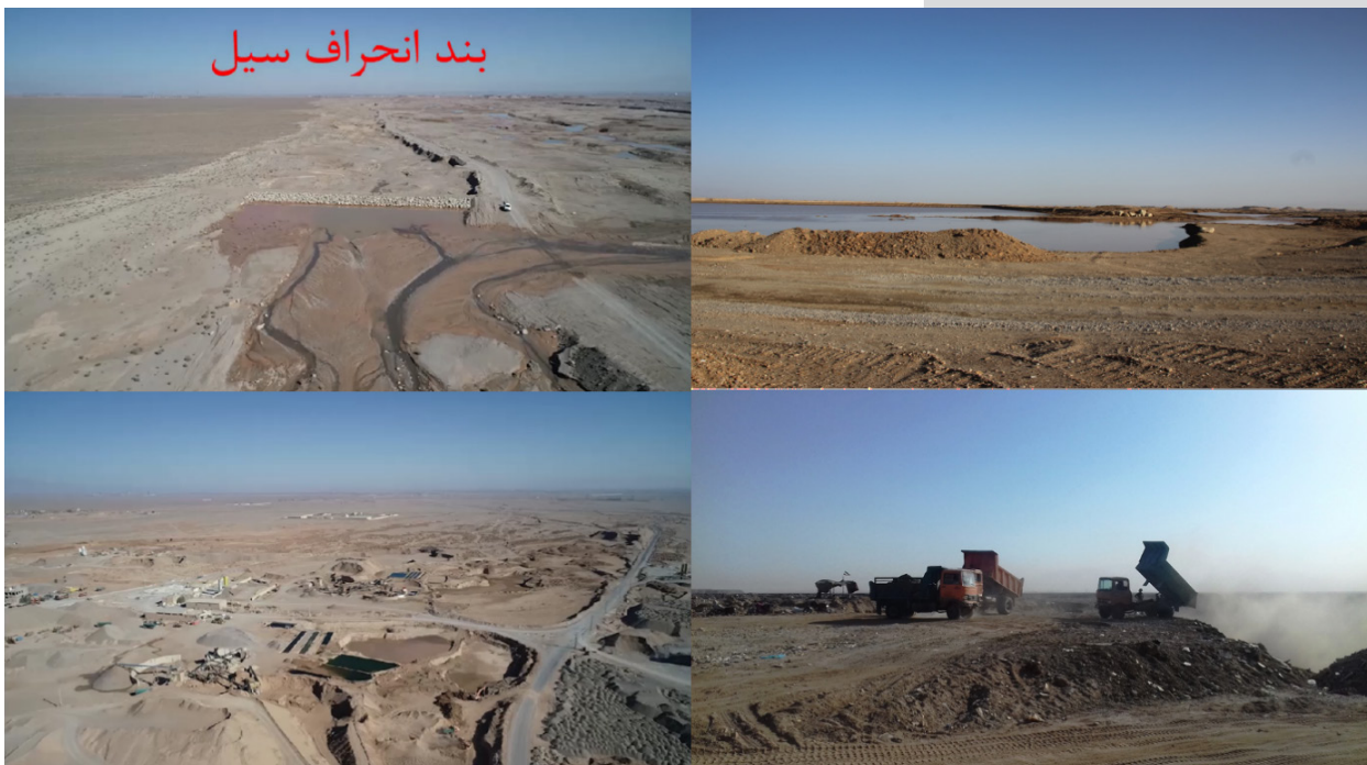
شکل ۳- نمایی از معادن شن و ماسه در انتهای مسیل کوه کاسه و تخلیه نخاله های ساختمانی (دو عکس پایین)؛ انحراف سیل به معادن شن و ماسه رها شده به منظور ترمیم عملیات معدنی توسط اداره منابع طبیعی و آبخیزداری بر اساس ماده ۲۵ قانون معادن؛ سیلاب مورخ ۹۸/۱/۶ با حجم تقریبی ۱/۷ میلیون مترمکعب (دو عکس بالا)
