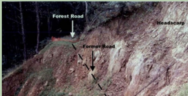
شکل ۵- تخریب جاده بر اثر زمین لغزش (ارسکین، ۲۰۰۵)
